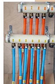
ヘッダー配線システム
