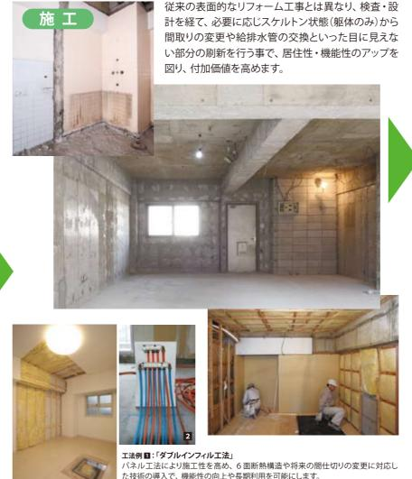
配管・配線を集約化し、給排水管の取り替え等、長期メンテナンスが容易となります。
